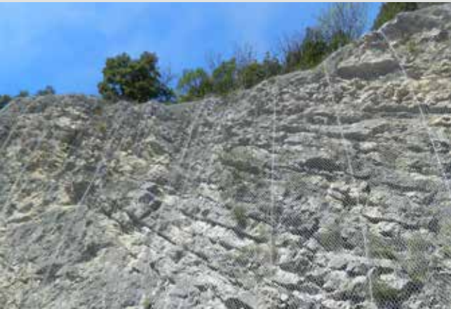
Foto 6 - Passaggio Calcare M. Corniola diga del Furlo (PU)
